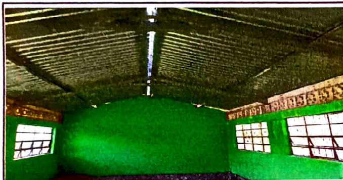
FOTO 1: Techo con estructura metálica colocado en el aula de sexto primaria.
