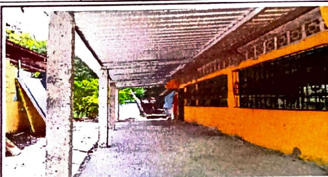
FOTO 2: Exterior del aula de sexto primaria con parales de cemento y entortado del corredor.
